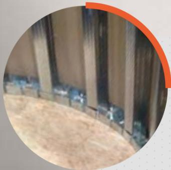
Die standardmäßigen vertikalen Pfosten lassen sich leicht in die flexible Profile COBRA schieben, um eine gekrümmte Wand zu erzeugen. Sobald sie sich in der gewünschten Position befinden, rasten sie **automatisch** ein und bleiben perfekt senkrecht.
