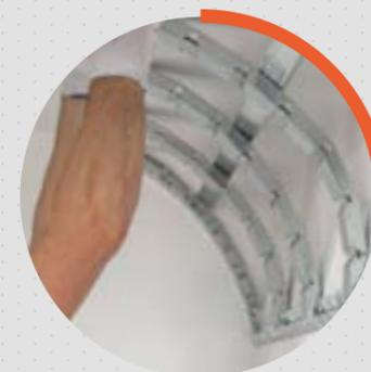
Sie können leicht **von einer Person gebogen** und an der Wand befestigt werden, was die Bauzeit aller gekrümmten Strukturen verkürzt und die Arbeitskosten erheblich spart.
