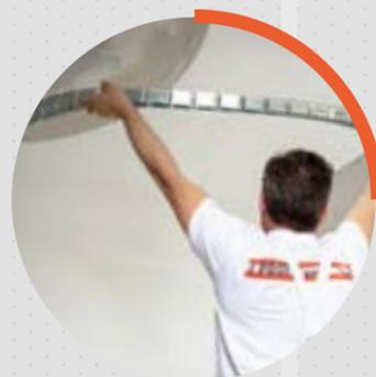
Sie können **leicht mit der Hand** in alle Richtungen gebogen werden. Sie **behalten die gewünschte Krümmung bei** und benötigen keine zusätzlichen Befestigungswerkzeuge.
