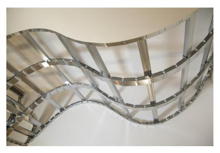
• Seguir con la instalación de las placas de yeso laminado (espesor 6mm/10mm), que encontrarán una estructura continua para una aplicación optimal.
