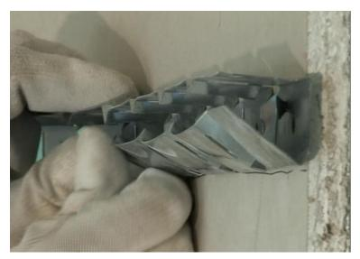
Construir la arcada con doble estructura metálica, compuesta de una estructura primaria C49x27 o C60x27 y de una estructura secundaria con Montantes Flexibles CONCAV / CONCAVEX 60x27mm y ganchos ortogonales (como para un falso techo continuo).
