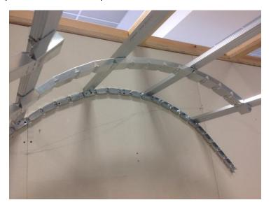
Conectar los Montantes Flexibles entre ellos a través de una pieza de empalme 60x27 para obtener la curvatura con el radio deseado (si están utilizando el montante único CONCAVEX, no es necesaria ninguna conexión para cambiar la dirección de la curvatura, sino sólo para la continuación más allá de 3 metros)
