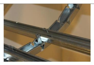
• La distancia entre cuelgues del falso techo tendrá que ser conforme a las dimensiones del cuarto y de las cargas adicionales.
