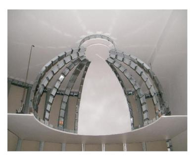
NOTA: Si la cúpula es de grandes dimensiones, es necesario posicionar trasversalmente unos montantes CONCAV / CONCAVEX 60x27mm sobre los montantes ya posicionados (doble estructura), y fijarlos entre ellos con ganchos ortogonales.
