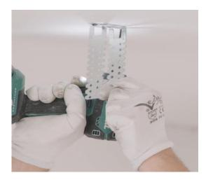
• Fijar los montantes C por un lado al canal COBRA 30mm inferior ya asegurado a la placa y, por otro, a los soportes.
